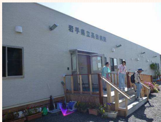
写真① 岩手県立高田病院 仮設診療所。陸前高田市米崎地区にある。現在は内科、外科、整形外科、小児科など外来のみ。今後病棟も立てる計画が決まった。
